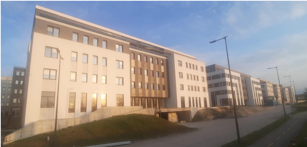
A C-D-E épületek jelenlegi állapota
