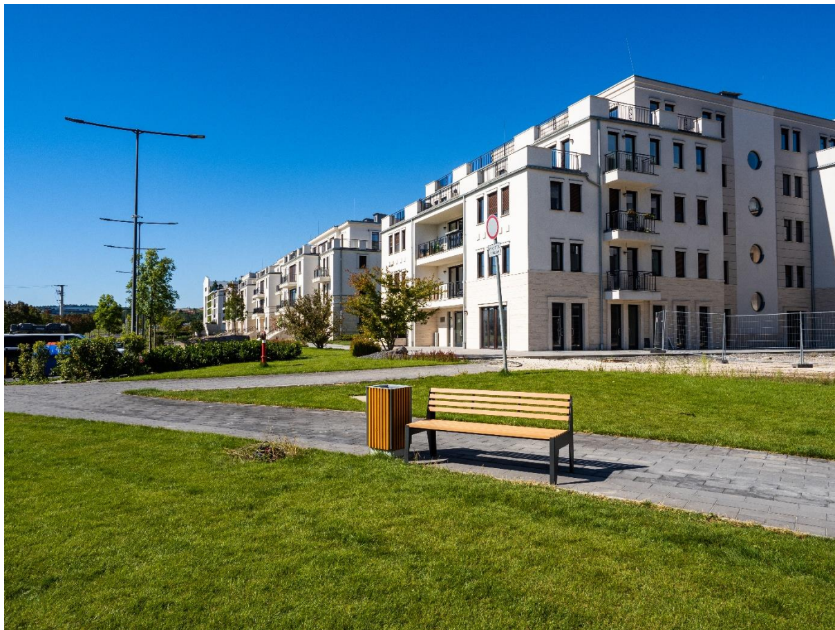
A J1-J4 épületek jelenlegi állapota
