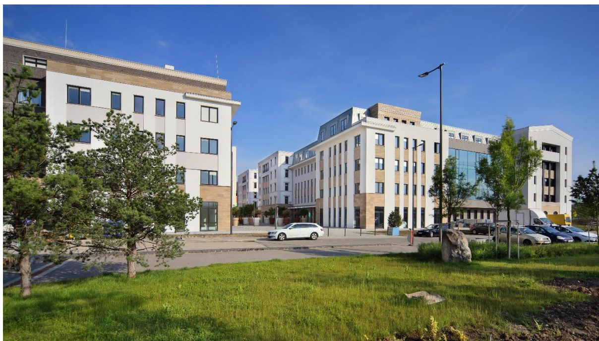
A B-C épületek jelenlegi állapota
