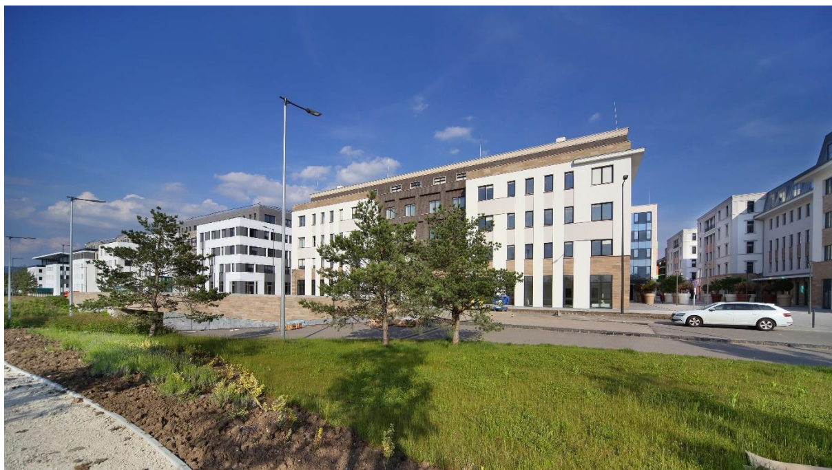
A C-D épületek jelenlegi állapota
