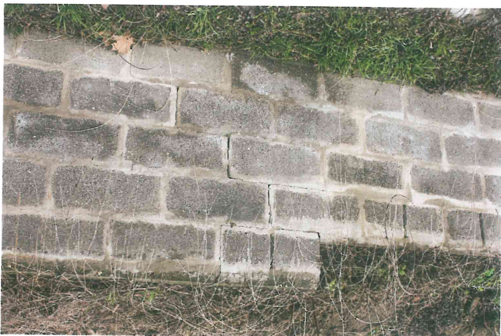
Repedések a támfalon
