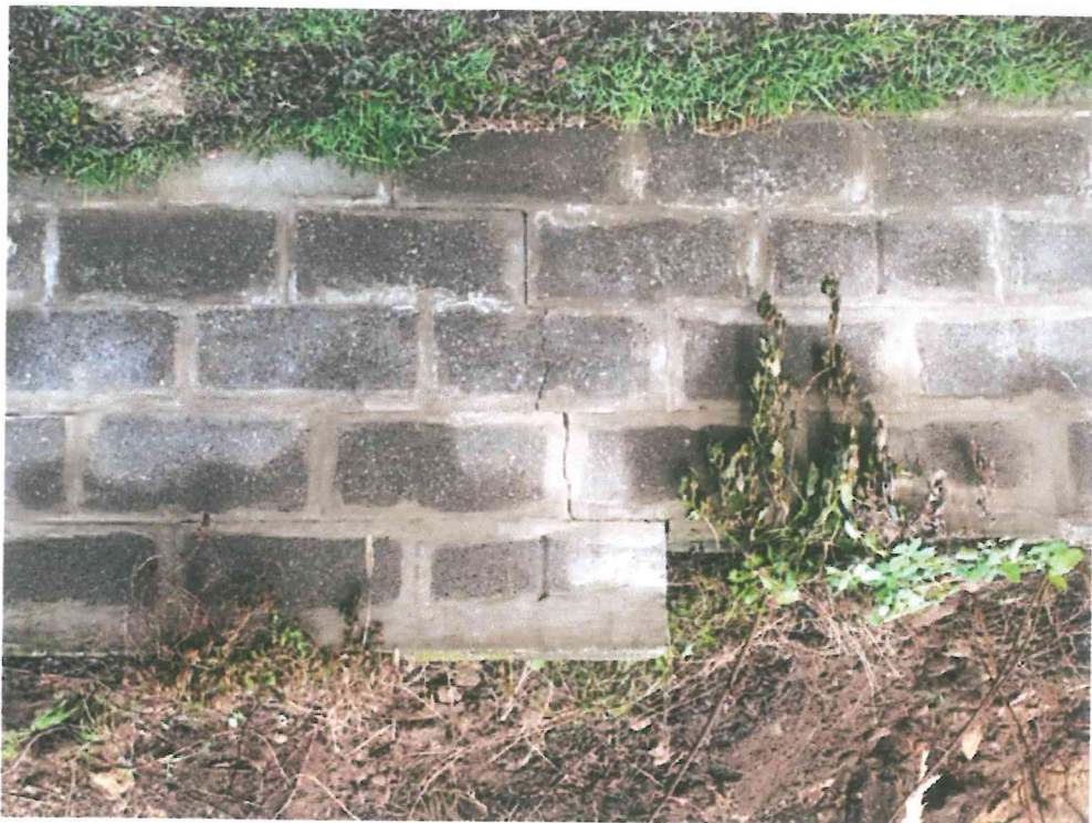
Megdőlt, repedezett támfal
