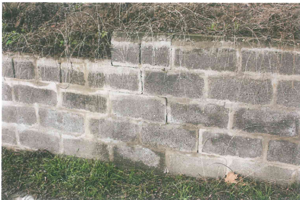
Repedések a támfalon
