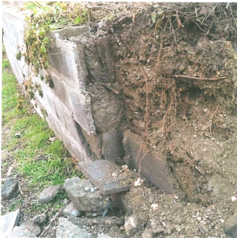
Erősen megdőlt támfal, minimális vasalással
