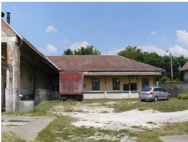
Főépület alapterülete kb:320 m 2 . Gyártás, raktározás és iroda, szociális blokk funkció kapott benne helyet. Fűtése központi, fabrikett kazánról történik. Műszaki állapota: erősen felújítandó.
