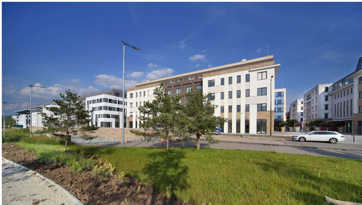
A C-D épületek jelenlegi állapota
