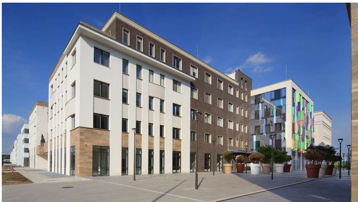
A C épület és a keresztpasszázs jelenlegi állapota
