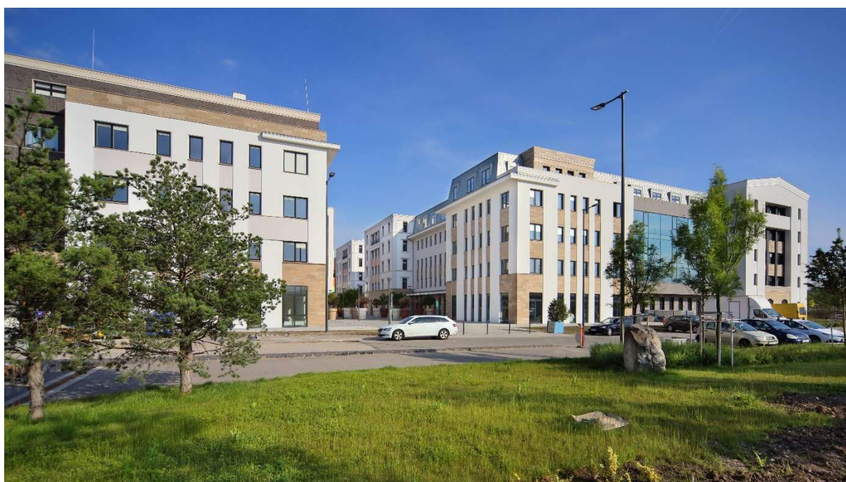
A B-C épületek jelenlegi állapota
