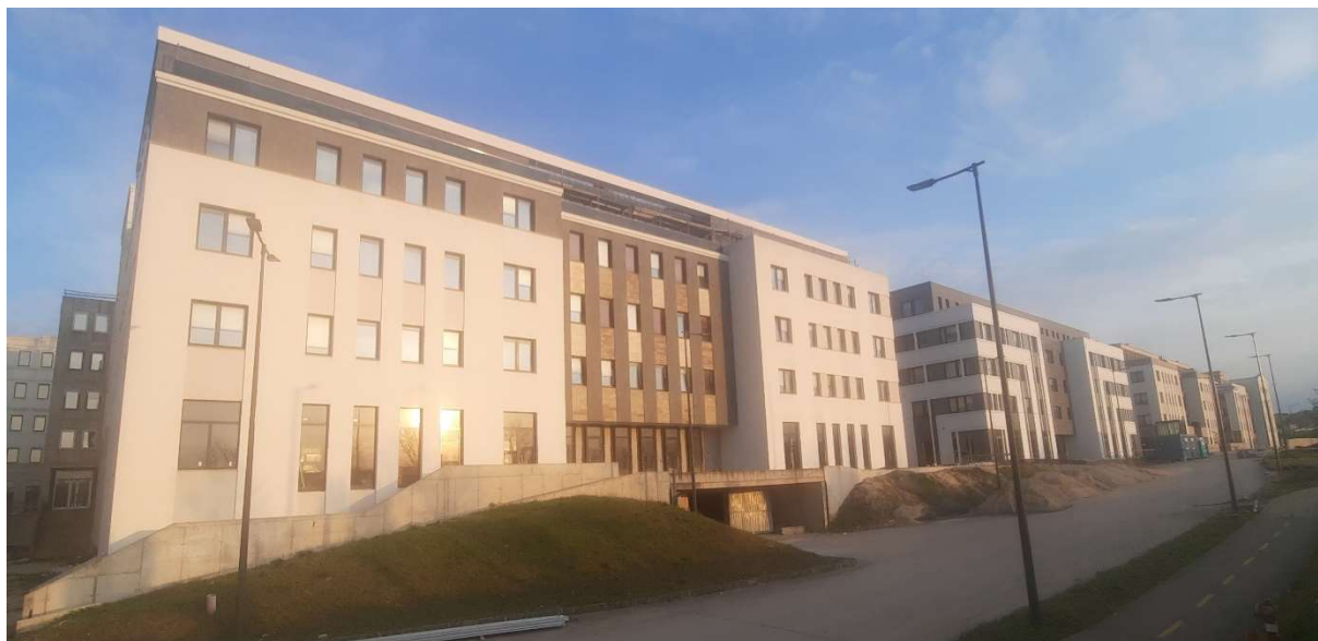
A C-D-E épületek jelenlegi állapota
