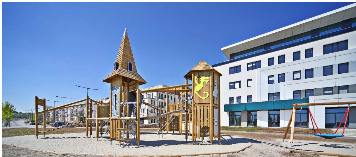
Az I épület és a játszótér jelenlegi állapota
