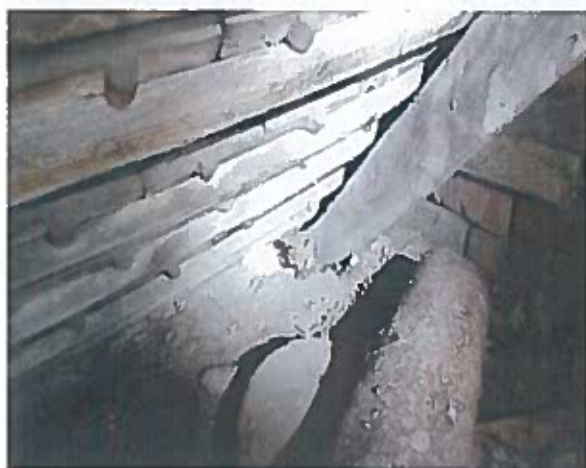
9. kép. Ormfali szaruállás (kettős fertőzöttségű) szarufavége (megroppant)
