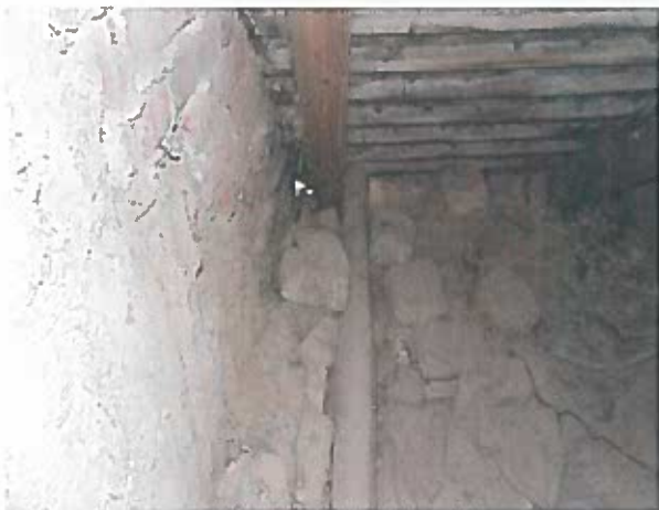
13. kép. Tűzfali szaruállás megerősítése szomszéd felől
