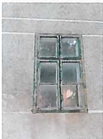
21. kép. 4. sorszámú utcai ki-be nyíló kétszárnyú ablak
