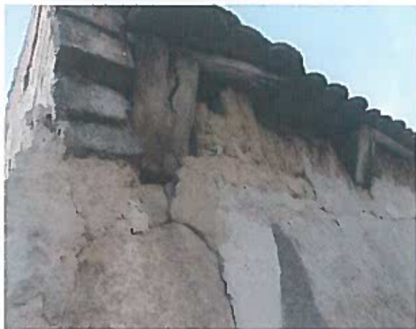
7. kép. Hátsó ormfali szaruállás takarás nélküli, hasadt gerendavég
