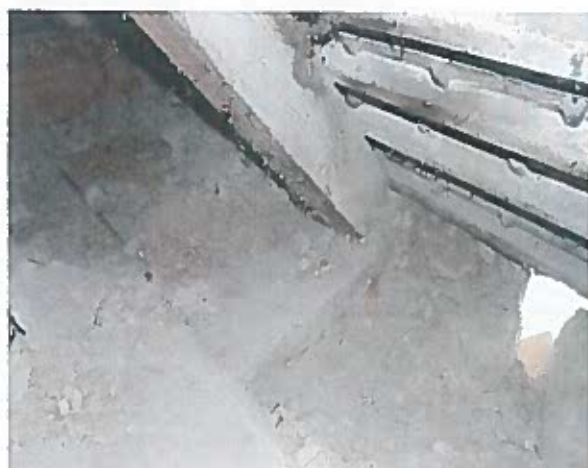
12. kép. Szarufa összeépítése borított fafödém gerendájával
