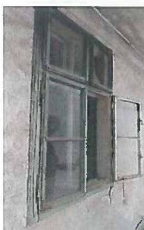
36. kép. 19. sorszámú udvari ki-be nyíló kétszárnyú ablak
