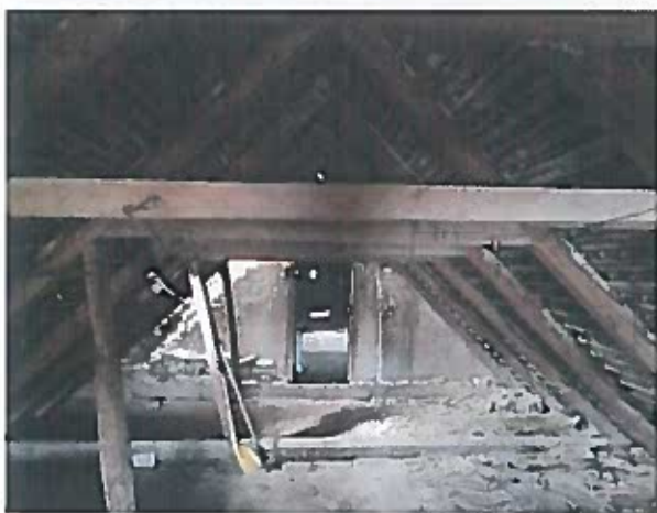
15. kép. Hevedergerendákkal megfogott szaruállások és dúcolásai
