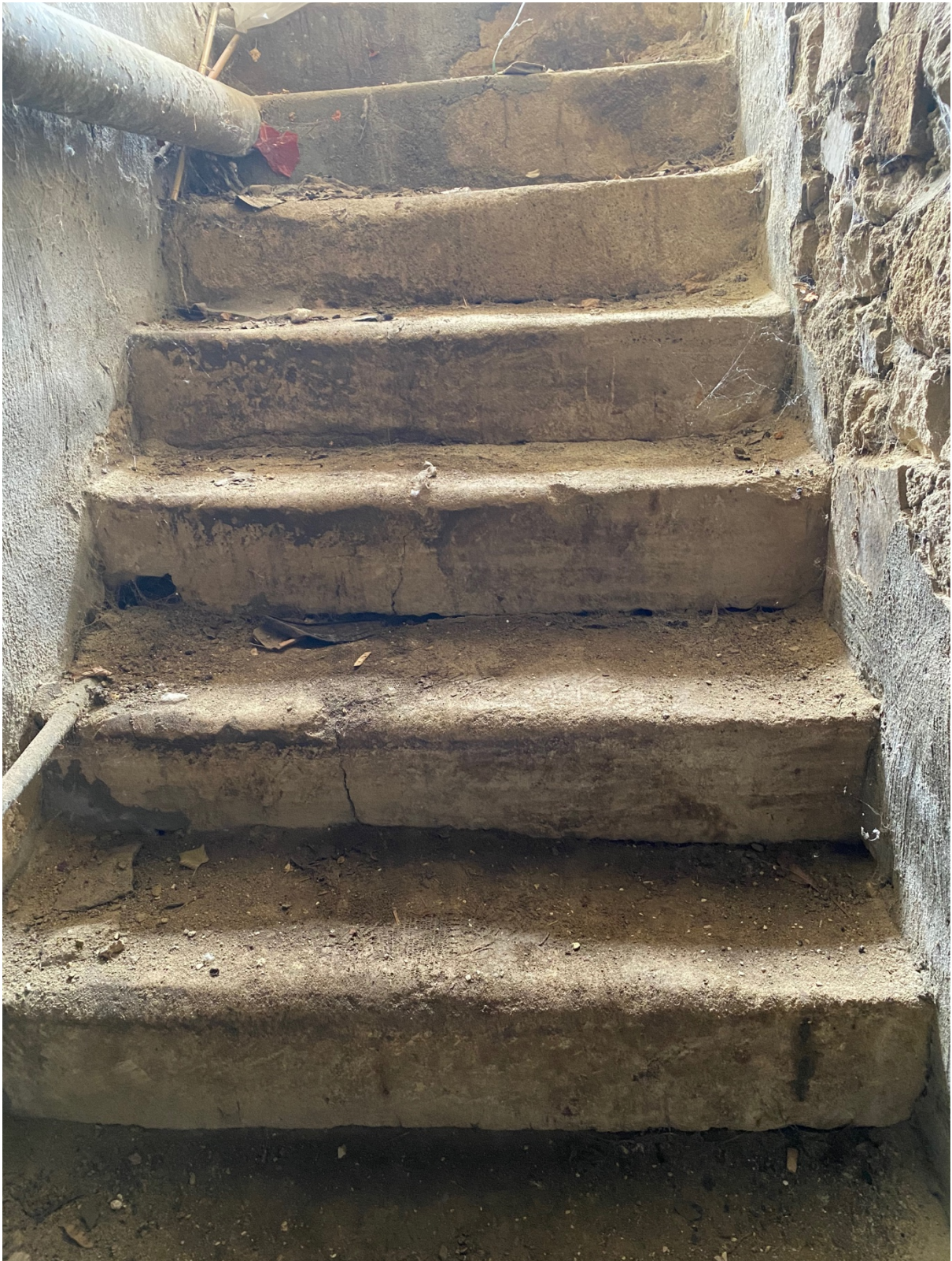
A pince lépcső elemei kopottságuk és repedéseik ellenére használható állapotban vannak
