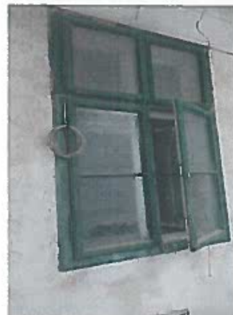
24. kép. 7. sorszámú udvari ki-be nyíló kétszárnyú ablak
