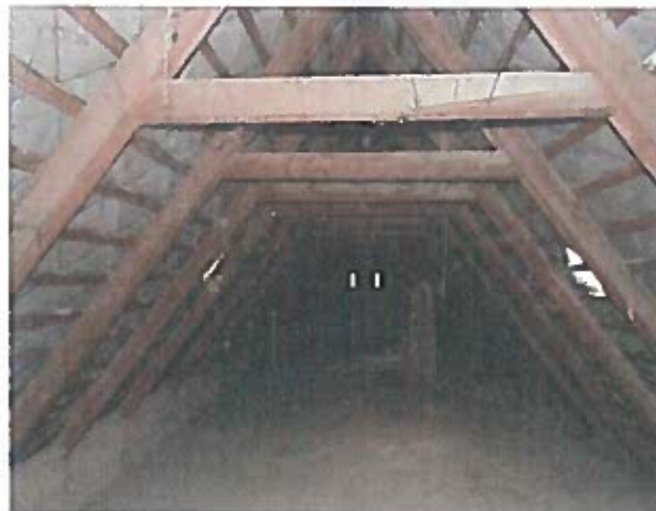
18. kép. Palafedésű padlástér egészséges fedélszékkel
