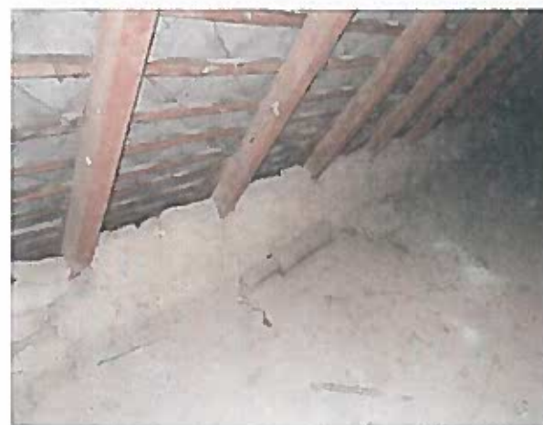
16. kép. Első padlás, szarufák között kitöltő térdfallal
