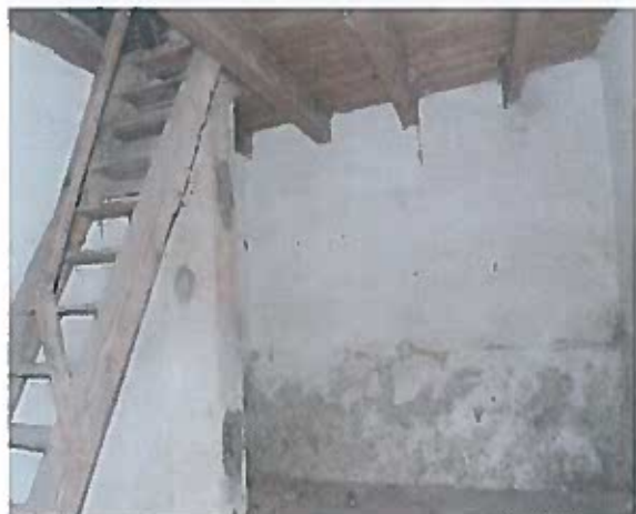
1. kép. Pórfödém kamara helyiség felett
