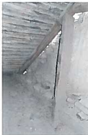
14. kép. Tűzfali szaruállás dúcolása udvar felől
