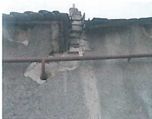
8. kép. Cserép ill. palafedés találkozási tűzfalnál látható gerendavég
