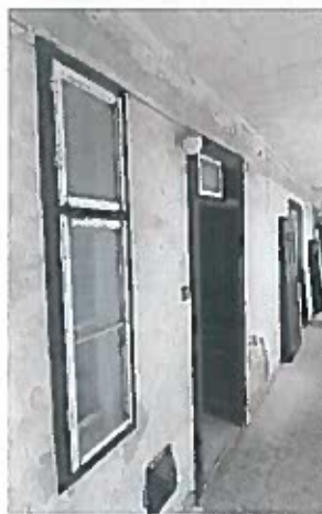
26. kép. 9. sorszámú udvari ki-be nyíló egyszárnyú ablak
