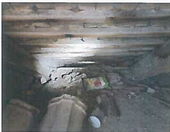
17. kép. Udvari oldal szarufavégei esőcsendesítővel a verenda fölött
