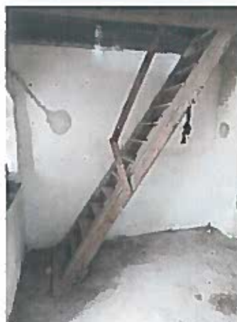
44. kép. Padláslépcső kapaszkodóval
