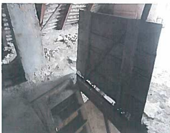
47. kép. Padlásfeljáró felnyíló deszkaajtóval
