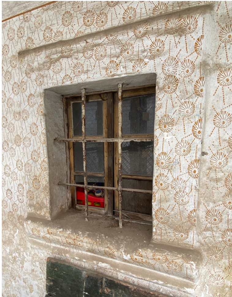
A hátsó kamra helyiség gangra néző vasrácsos ablakának kőkeretét elfedi a hengerelt falfestés
