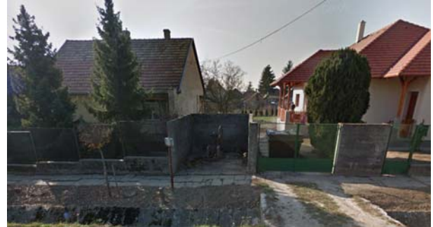
Betonkerítéssel határolt, régi közkút (forrás: Google Street View)
