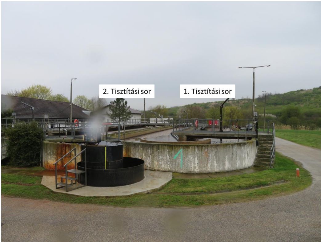
3-7. ábra Levegőztető (aerob/anoxikus) medence
