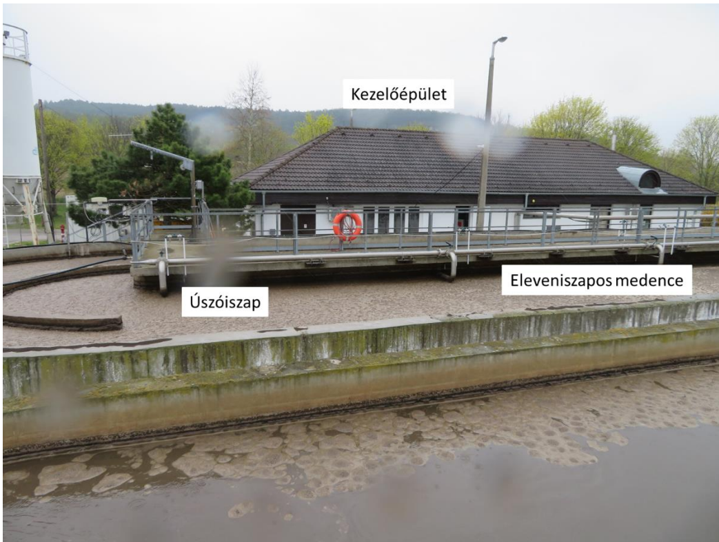
3-8. ábra Levegőztető (aerob/anoxikus) medence
