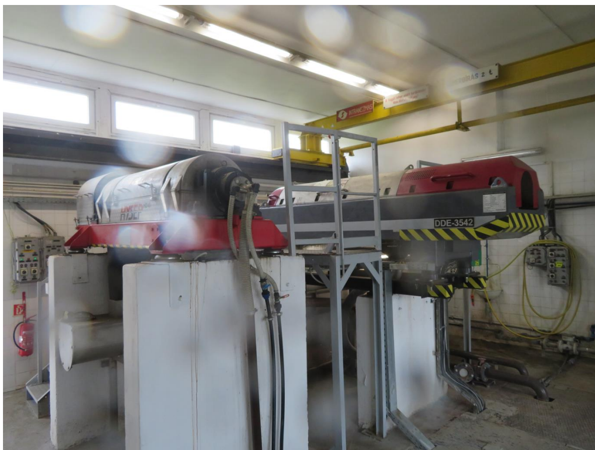
3-10. ábra Iszapvíztelenítő centrifugák
