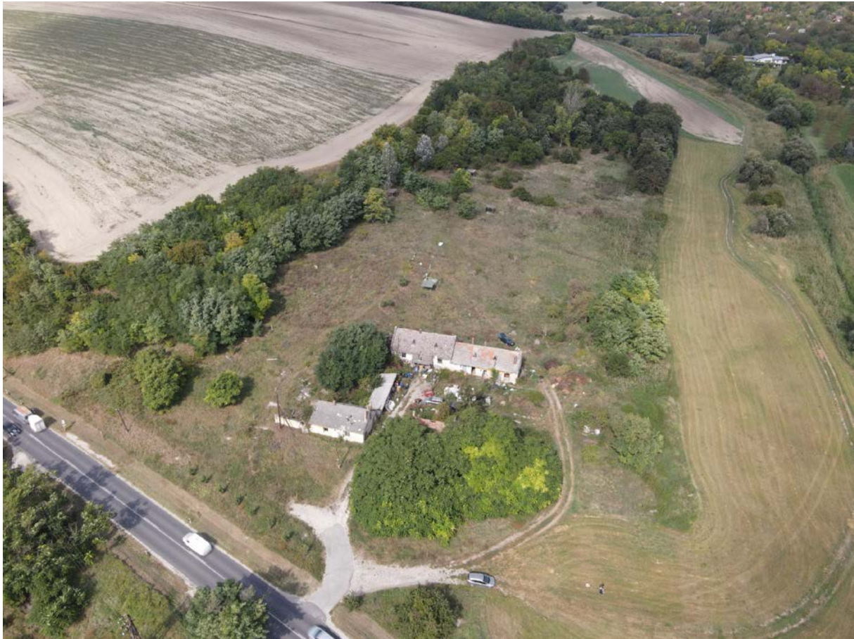
Drónfotó az Alsó-major területéről, az ingatlan kármentesítése megtörtént, de továbbra is alulhasznosított, leromlott állapotú (sf)
