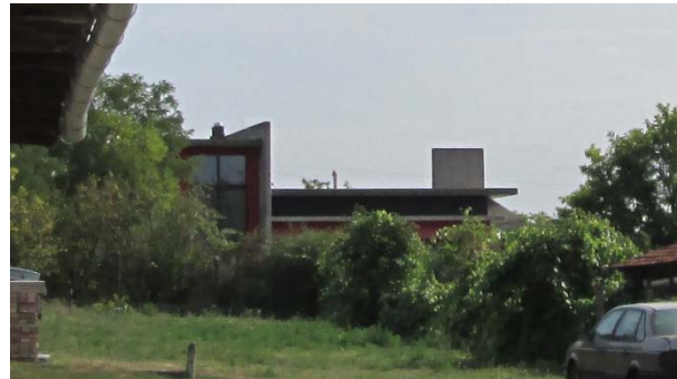
Újronnan létesített lakóépület a 311/5 hrsz.-ú telken (sf)
