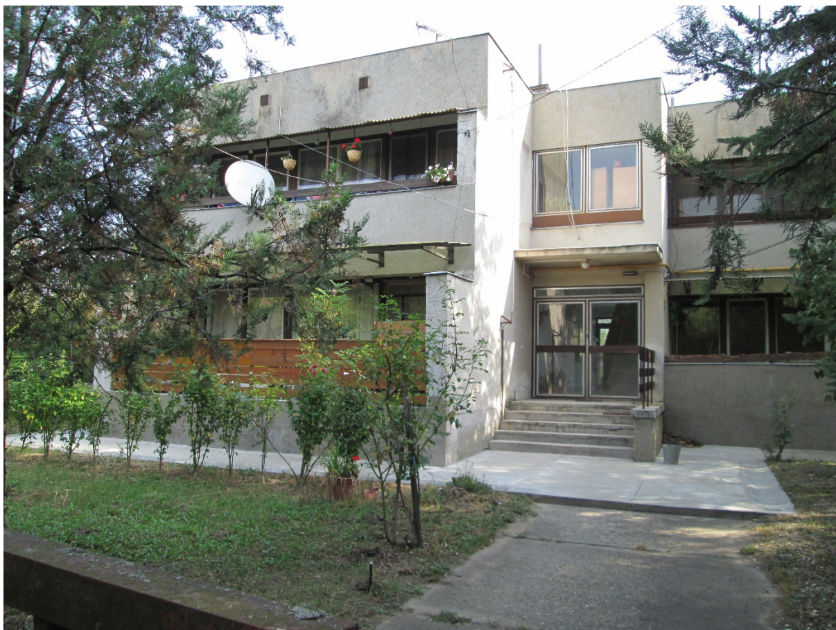
Leromlott állapotú MÁV szolgálati lakások (saját felvétel)
