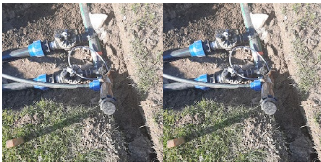
Az iharosi sporttelepen a locsolórendszer építése, kialakítása
